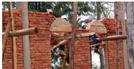
Gemeindemitglieder helfen beim Mauerbau einer neuen Kirche in Ruanda. Foto: VEM
